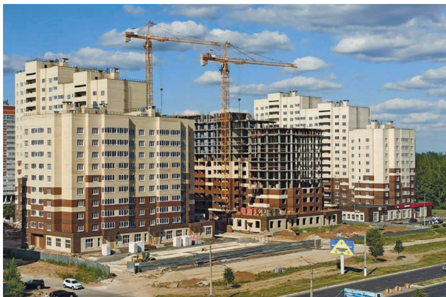
Жилой комплекс «Дом у Рощи», г. Новочебоксарск
