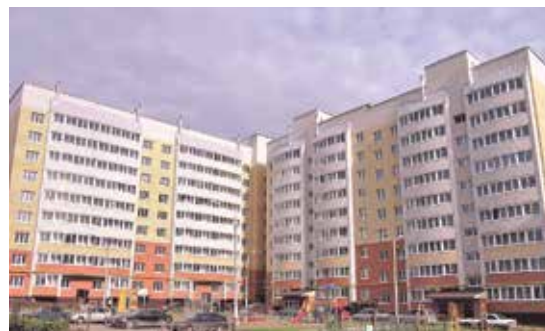
| Жилой дом по ул. Советская, д. 59а, г. Новочебоксарск
