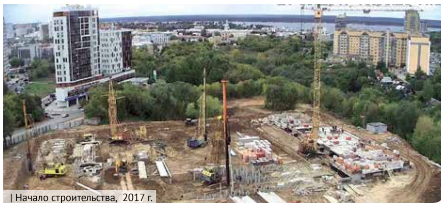
| Начало строительства, 2017 г.
