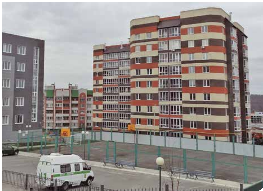
| Новостройки, ул. Мате Залка, г. Чебоксары
