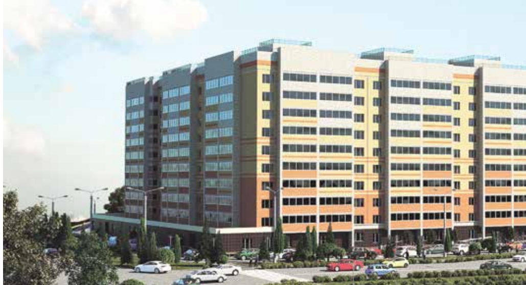
| Многоквартирный жилой дом по ул. Энгельса, поз. 31, расположенный в центральной части г. Чебоксары
