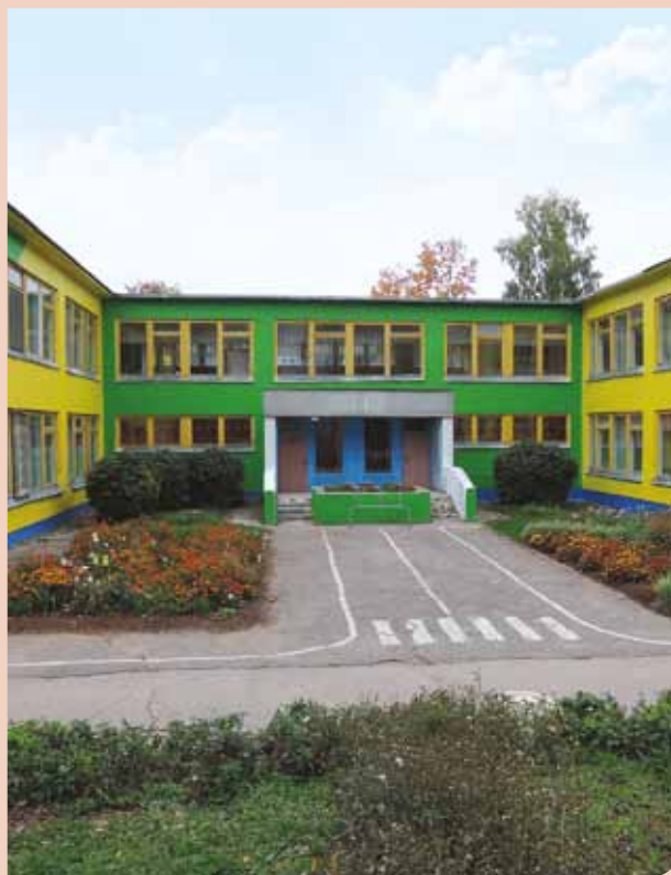
| Детсад после ремонта
